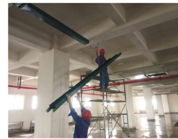
安徽中烟蚌埠卷烟厂项目辅料综合库消防管道安装现场
