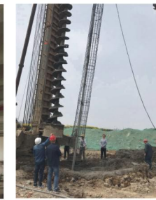
淮河试验研究中心项目长螺旋灌注桩施工现场
