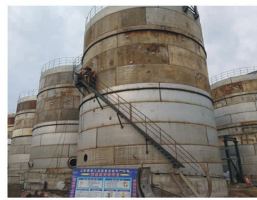
宿州中粮10万吨无水乙醇搬迁技改项目发酵罐盘梯现场制作
